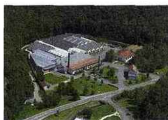
Vue aérienne de l'usine.
